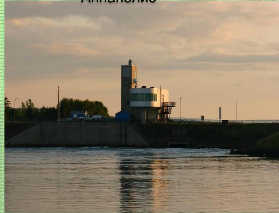
ПЭС Аннаполис — приливная электростанция. Была построена в Канаде в 1985 году. Сооружена в заливе Фанди. Перепад высот прилива и отлива в этом месте составляет до 18 метров. ПЭС Аннаполис электростанция с установленной мощностью в 20 МВт.
