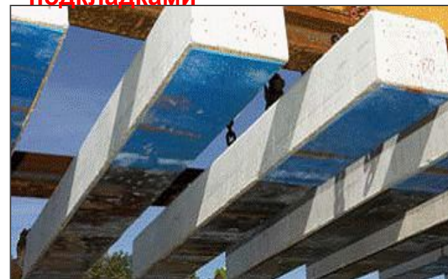
Шпалы с упругими подкладками
