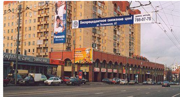
Тролл – рекламная конструкция, расположенная над дорогой с помощью вертикальных стоек. Оборудована подсветкой
