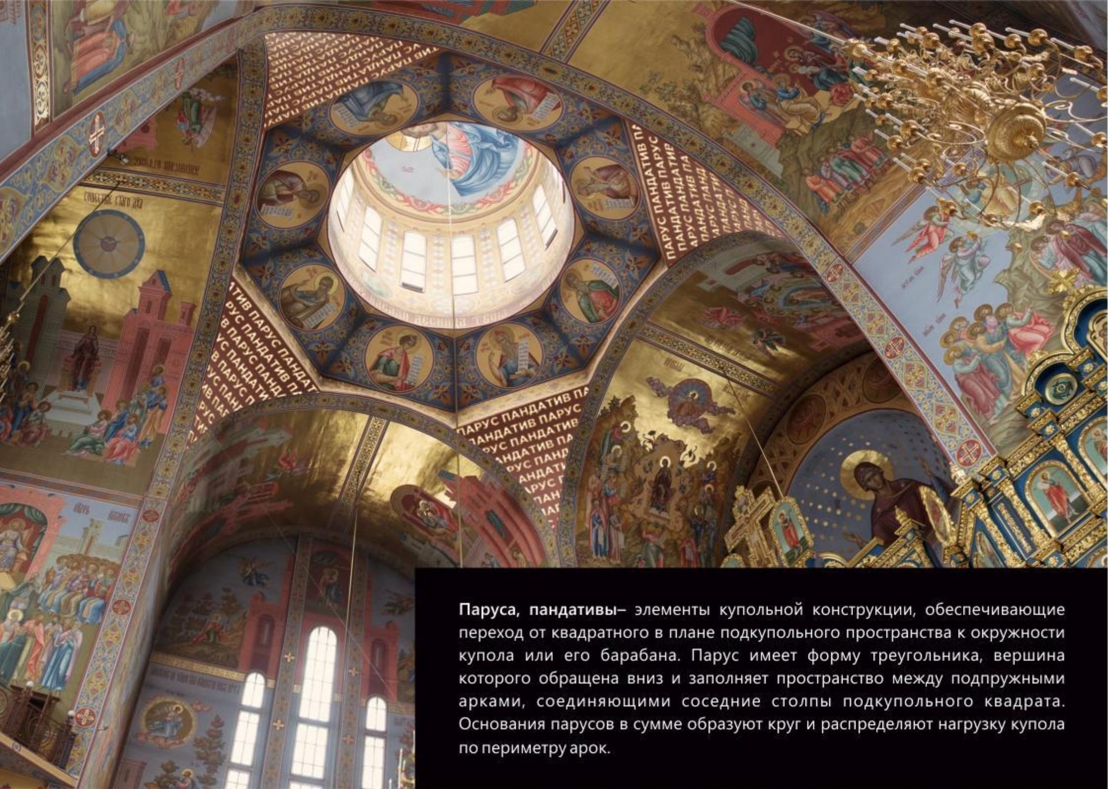
Паруса, пандативы– элементы купольной конструкции, обеспечивающие переход от квадратного в плане подкупольного пространства к окружности купола или его барабана. Парус имеет форму треугольника, вершина которого обращена вниз и заполняет пространство между подпружными арками, соединяющими соседние столпы подкупольного квадрата. Основания парусов в сумме образуют круг и распределяют нагрузку купола по периметру арок.
