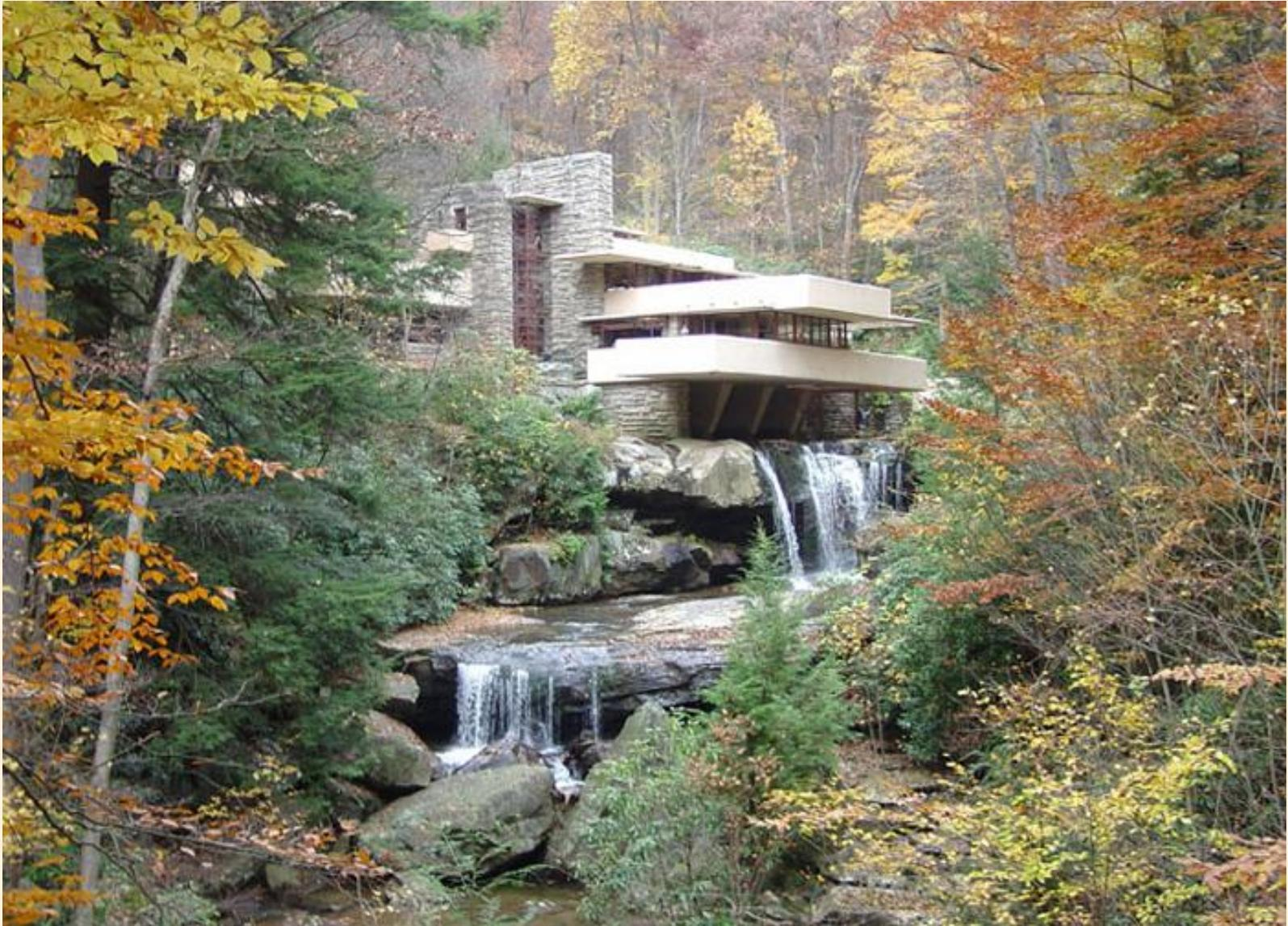
Дом представляет собой композицию из бетонных террас и вертикальных поверхностей из известняка, расположенных на стальных опорах прямо над ручьем. Часть утеса, на котором стоит дом, оказалась внутри здания и использовалась Райтом как деталь оформления интерьера. Райт стремился к тому, чтобы при строительстве дома не было бы срублено ни одного дерева, все крупные горные валуны остались бы на своих местах, а будущий дом стал бы просто частью естественного ландшафта.
