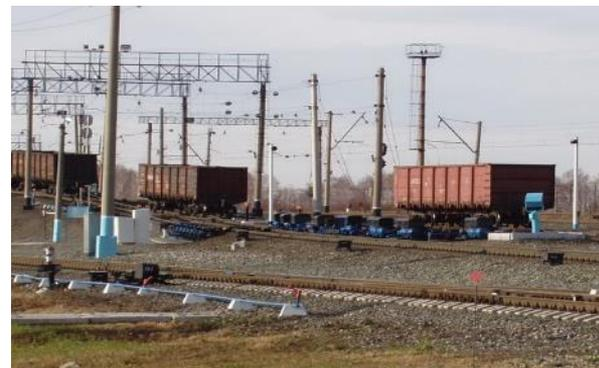
КСАУ СП обеспечивает управление технологическим процессом расформирования составов на горках, имеющих дистанционное управление стрелками и замедлителями на тормозных позициях, и имеющих на путях сортировочного парка оборудование контроля заполнения путей (КЗП). Возможные режимы роспуска составов - автоматический, программный, маршрутный.
