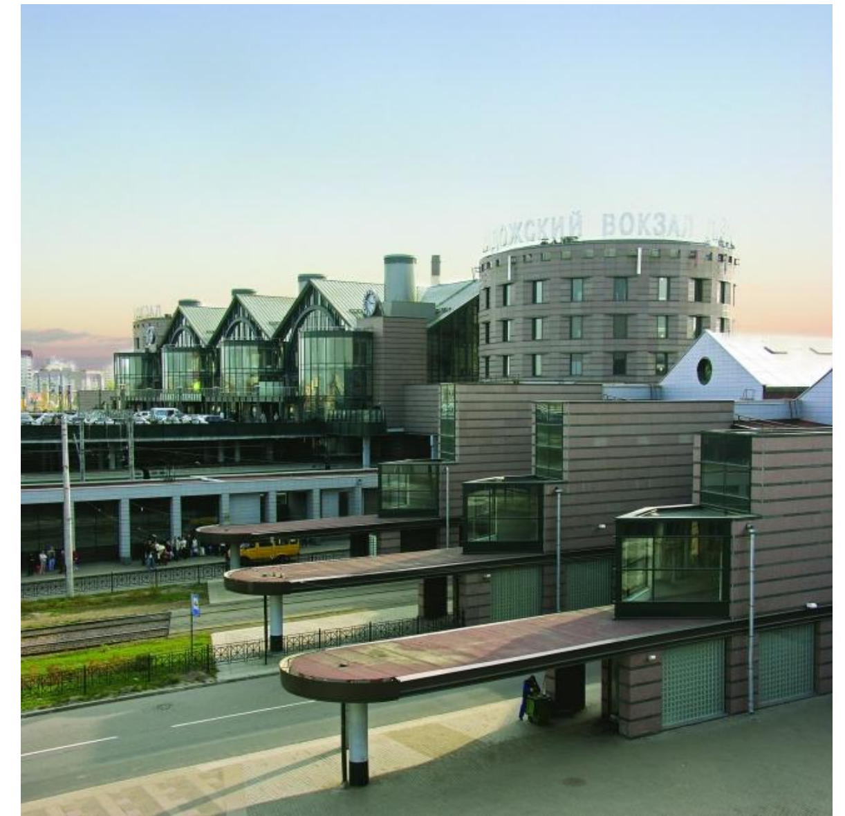
Вокзальный комплекс Ладожский, Санкт-Петербург Студия 44 Санкт-Петербург, Россия 2001 — 2002 / 2001 — 2003
