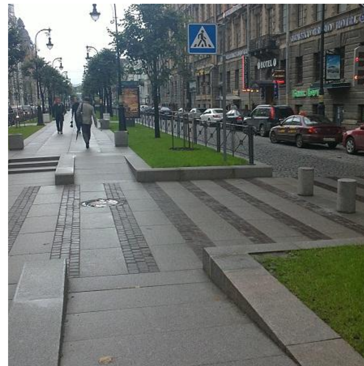
Реконструкция Большой Конюшенной улицы Санкт-Петербург, Россия 2010-2011
