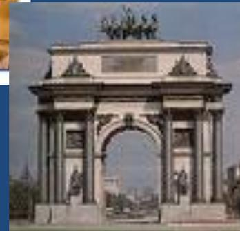
Представьте себе, что много, допустим десять или двадцать, арок поставлены вплотную одна за другой. Получится коридор или туннель с полукруглым потолком. Такое перекрытие называется свод. Теперь разрежем арки вертикально точно посередине и эти половинки поставим вплотную друг к другу так, чтобы наружные стены описали полный круг, как дольки апельсина, разрезанного горизонтально. Тогда получим наверху купол. Вот именно купол и был третьим великим открытием римлян
