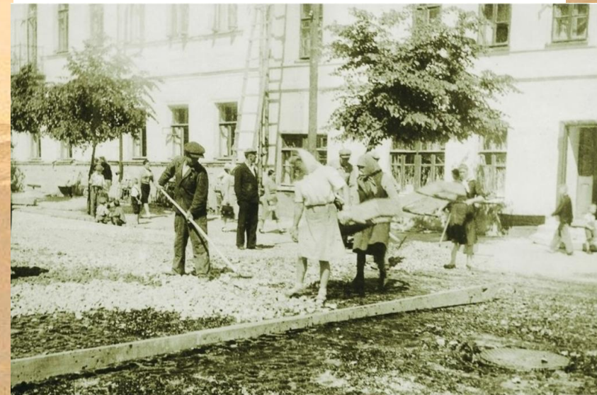
Подготовка дорожного полотна в центре города под асфальтирование 1945 г.
