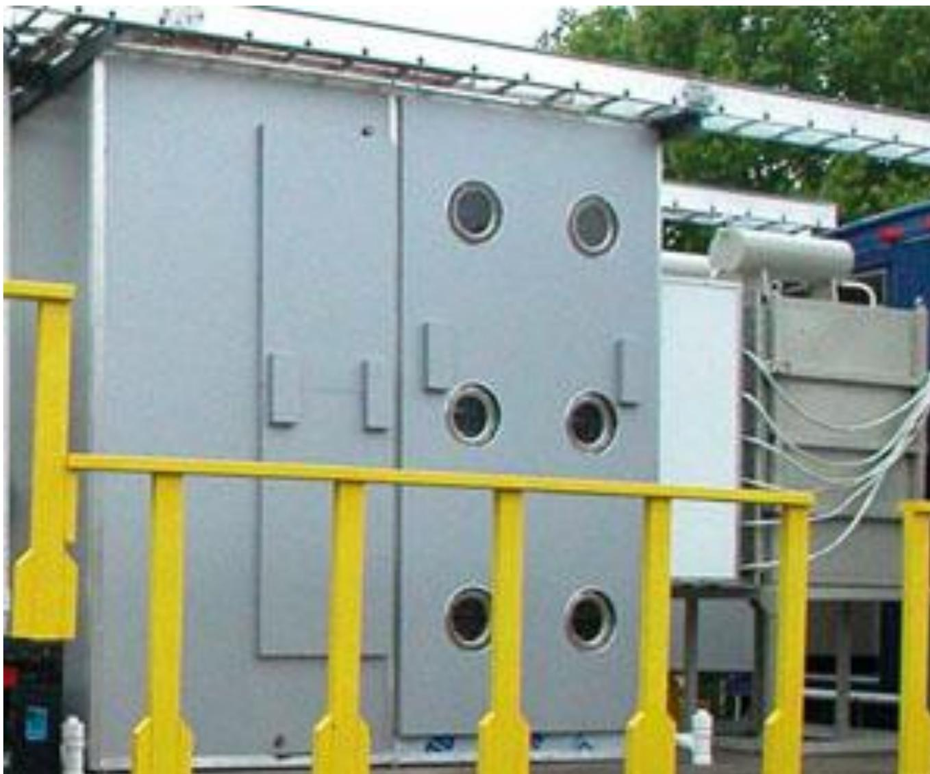
**Результаты применения технологии очистки (на примере двустадийной системы: первая стадия - электростатический фильтр, вторая стадия - импульсный коронный разряд) для вентиляционных газов алюминиевого завода**
