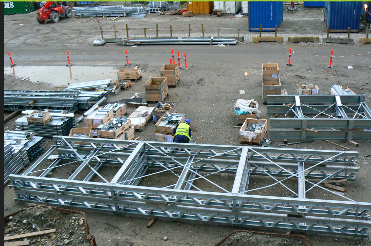
Модули, подготовленные к подъему и адаптации к основной конструкции.
