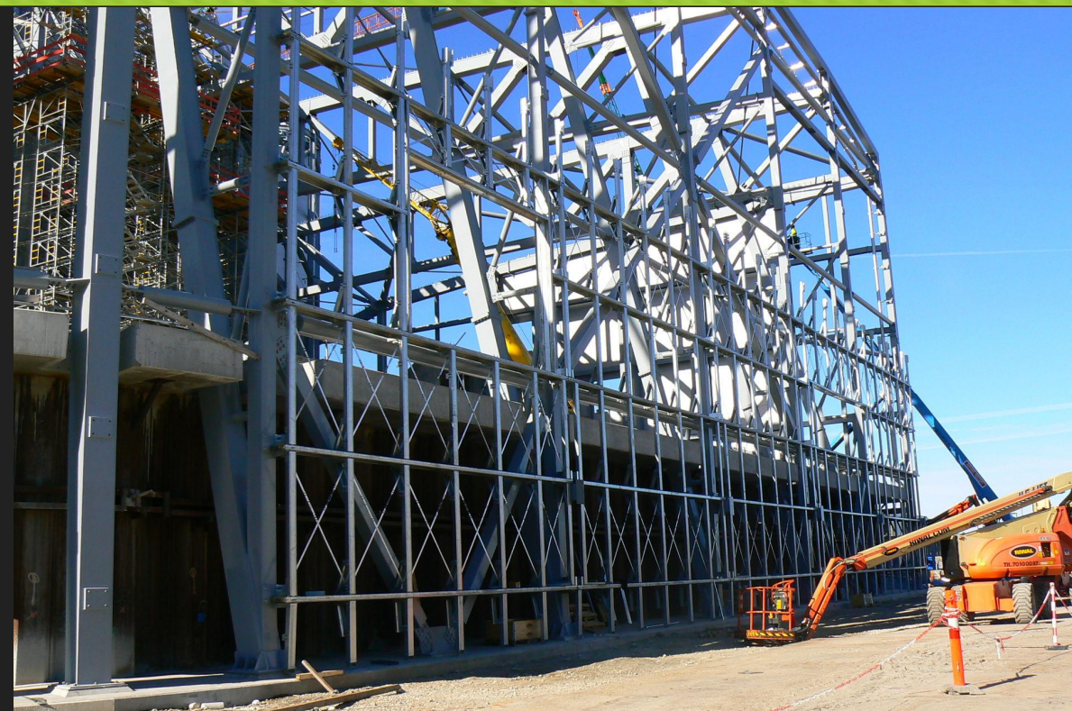
начало монтажа на восточном фасаде
