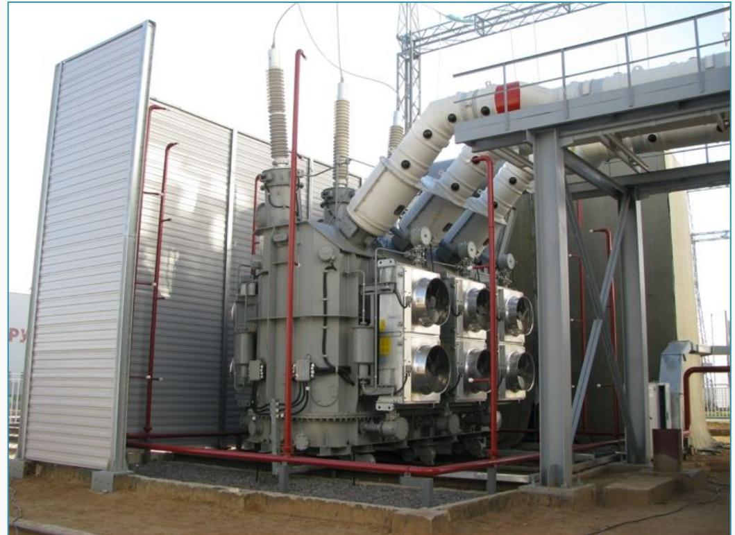
**Блочный трансформатор 200МВА, 220 кВ**
