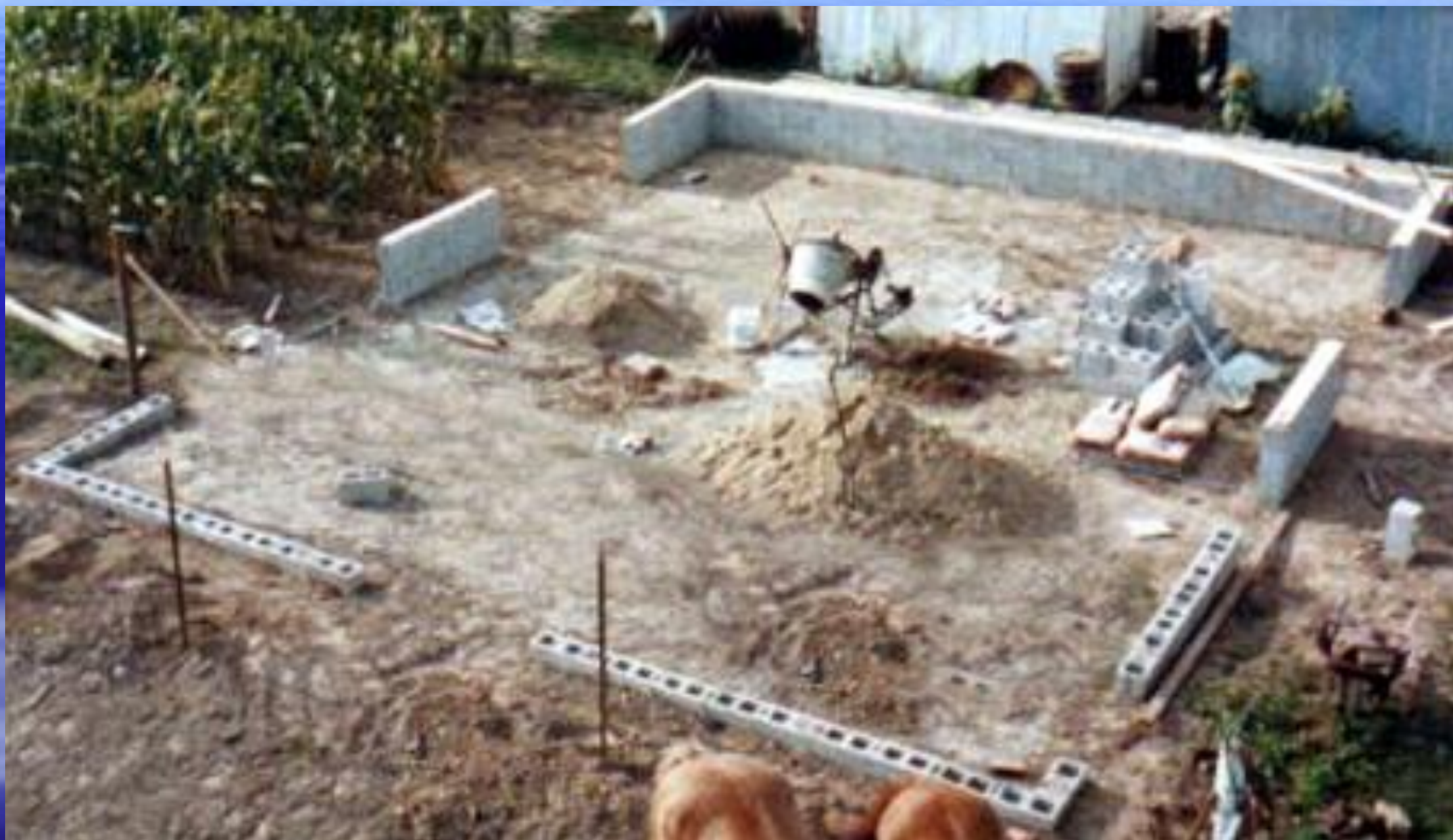
Закладка фундамента здания
