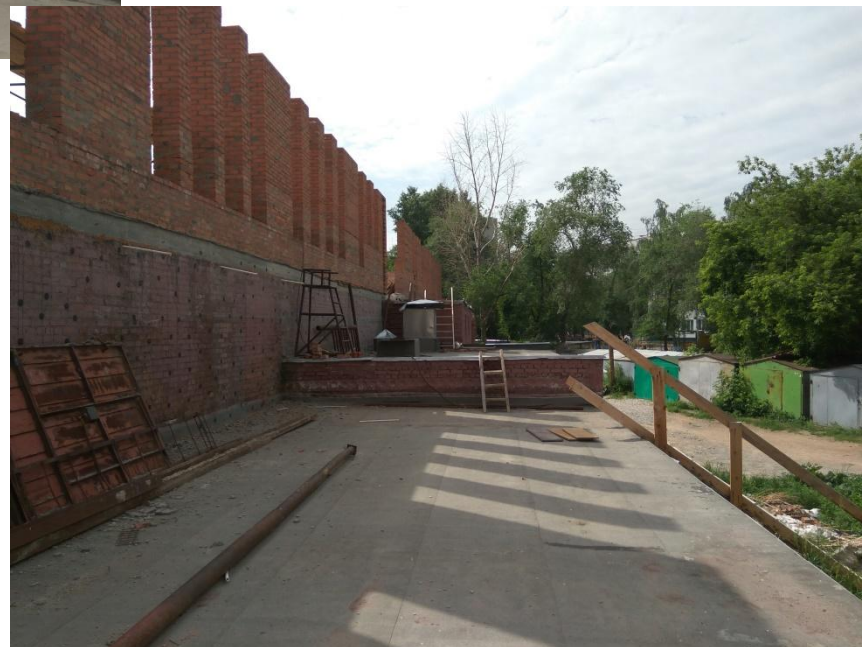
Административное здание, Новосибирск, ул. Галушца, 3/1.
