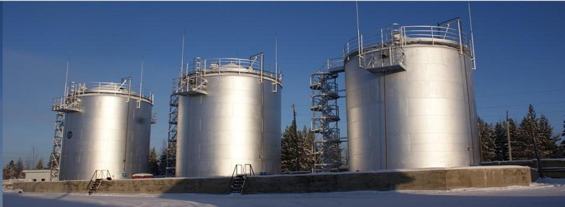
**Рис. 8.30. Вертикальные цилиндрические резервуары повышенного давления**
