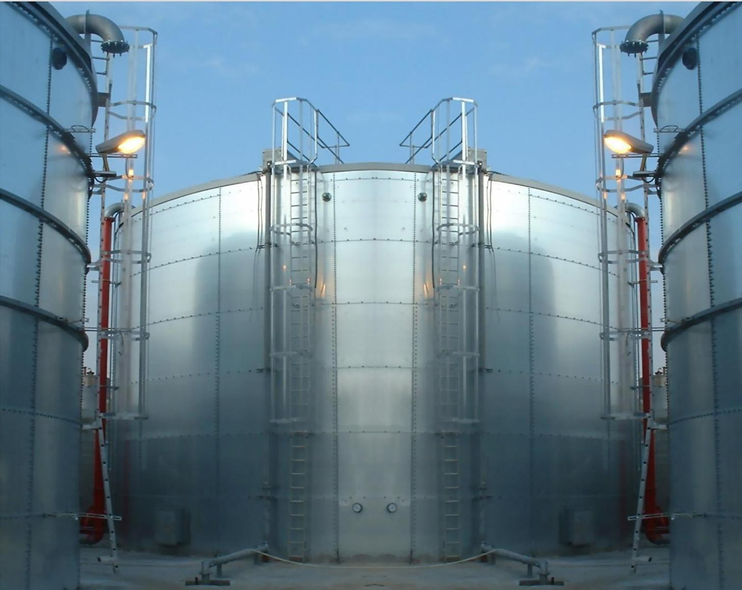
Резервуарами называются сосуды, предназначенные для хранения нефти, нефтепродуктов, сжиженных газов, воды, жидкого аммиака, кислот, технического спирта и других жидкостей.
