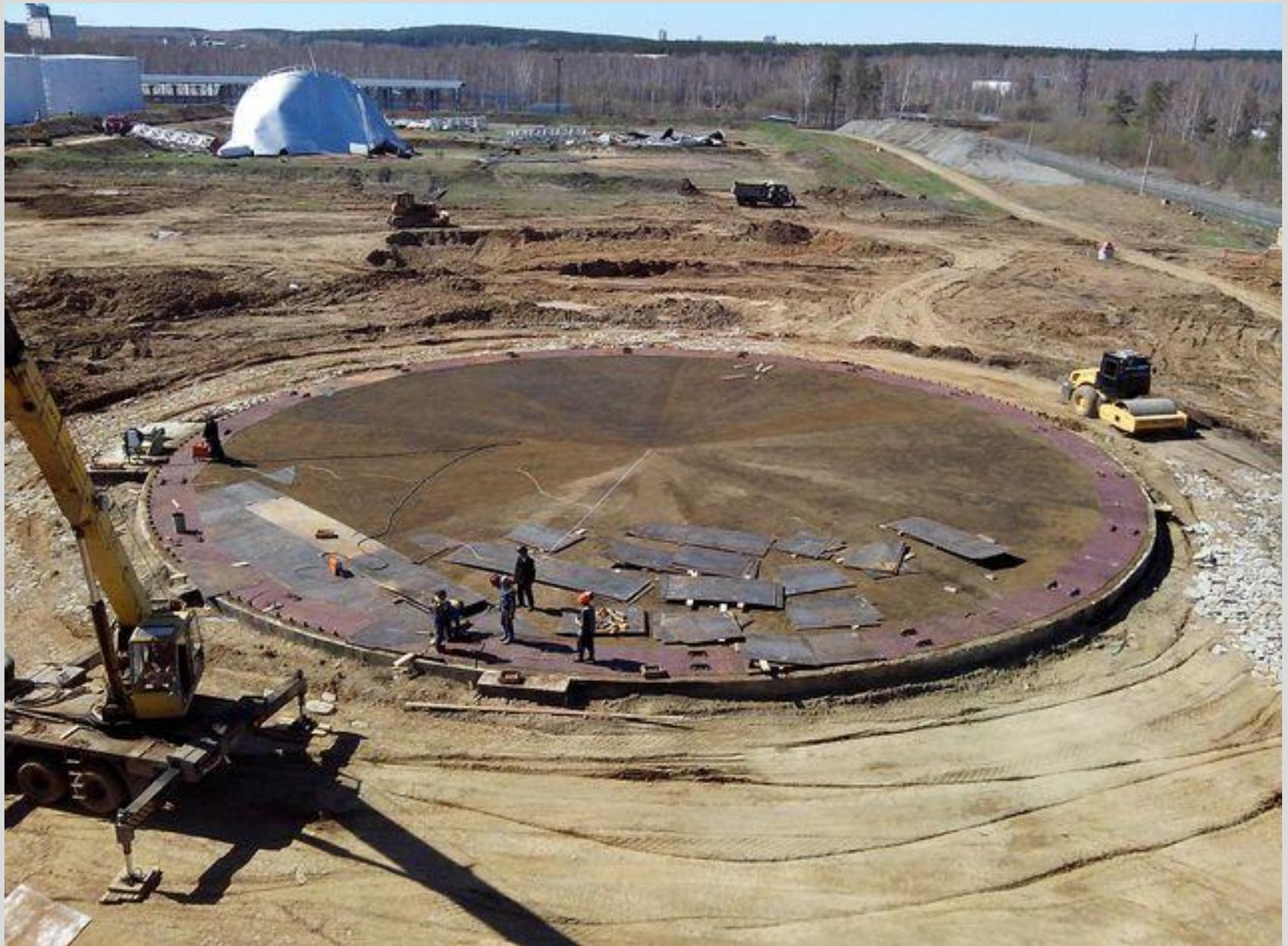
Рис. 8.14. Общий вид днища резервуара
