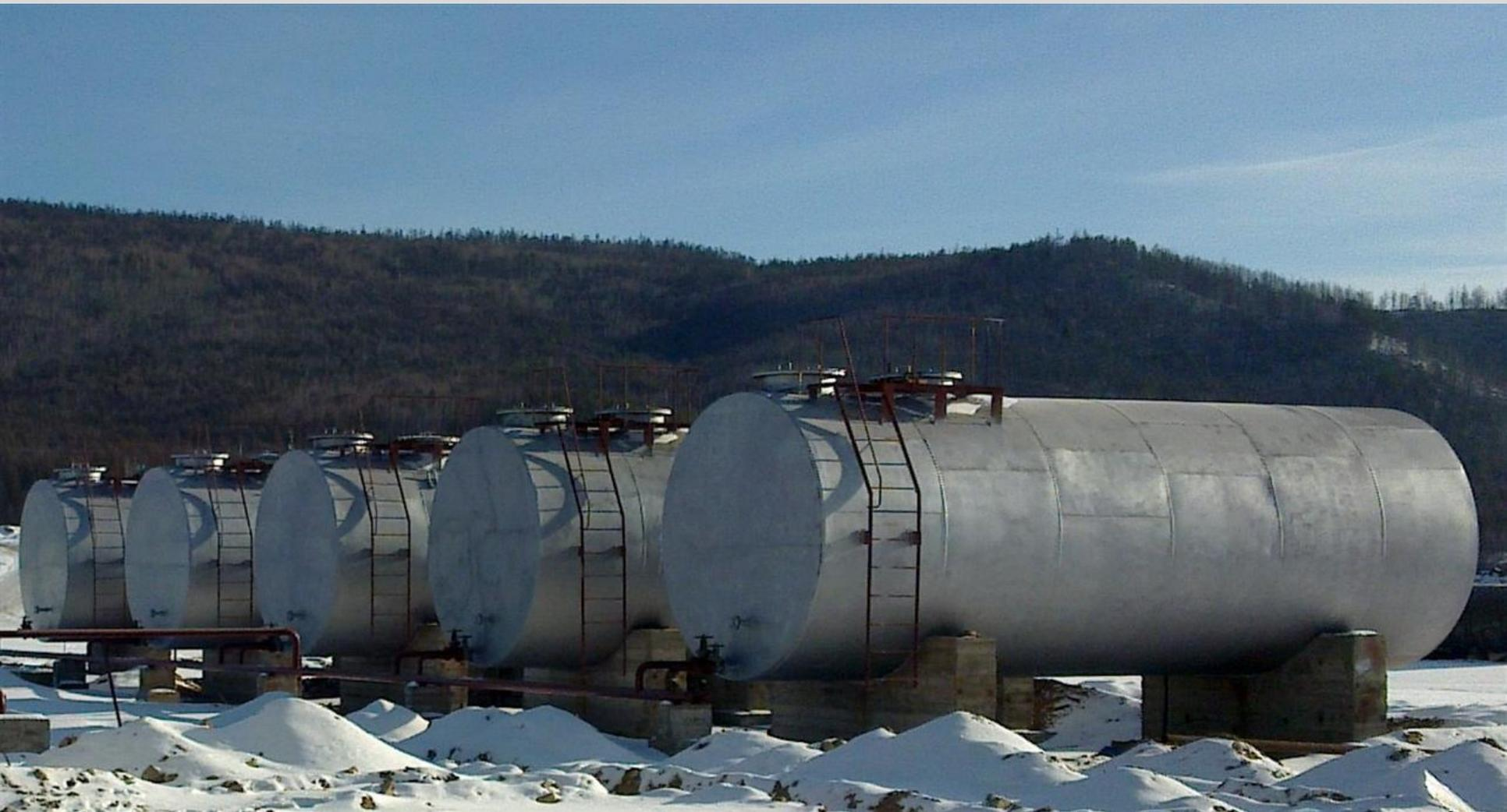
Рис. 8.33. Горизонтальные цилиндрические резервуары
