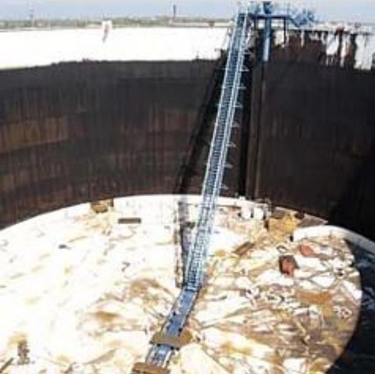
При кратковременном хранении больших объемов нефтепродуктов (от 10 до 100 тыс. м<sup>3</sup>) значительное сокращение потерь от испарения достигается в резервуарах с плавающей крышей.
