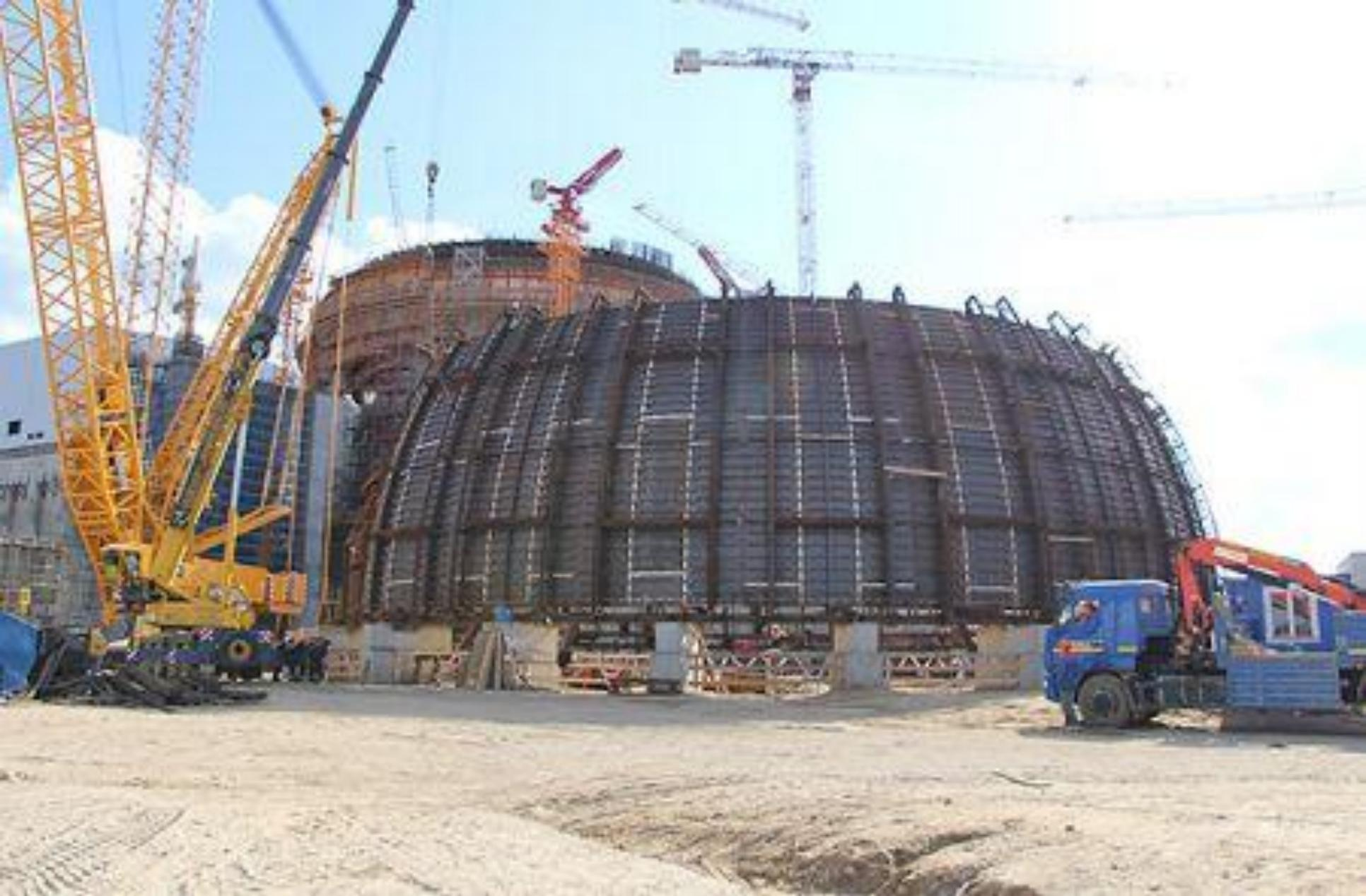
**Рис. 8.8. Защитные сооружения-оболочки АЭС**
