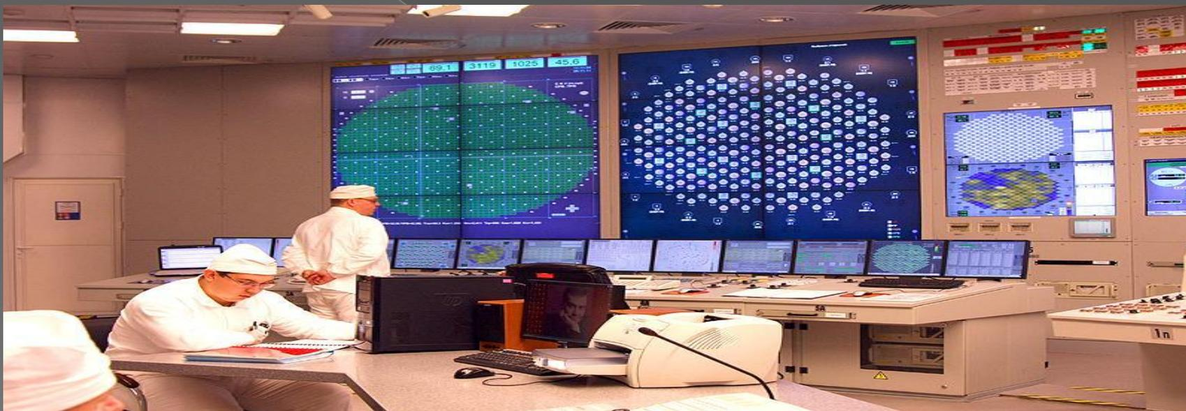
Блочный пульт управления предназначен для централизованного автоматизированного управления технологическими процессами. В случае выхода пульта из строя – остановка блока и контроль за состоянием его систем и оборудования осуществляется с резервного щита управления.
