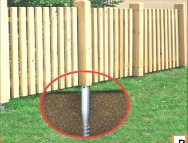
Рис. 4. а) ограждение стройплощадки по деревянным стойкам: 1-стойка; 2-прогоны из брусков; 3 - доски забора; 4 -подкос; 5-опора; 6 –гвозди. б) ограждение стройплощадки металлическим профилем по металлическим сваям. в) ограждение стройплощадки деревянным забором по винтовым металлическим сваям.
