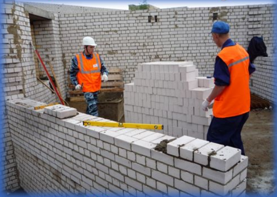
Мастер общестроительных работ
