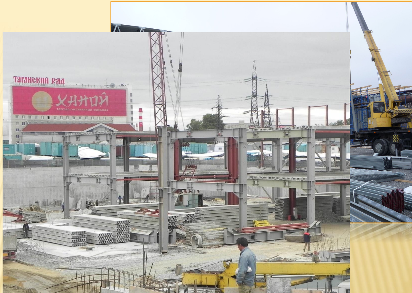
СКЛАД СТРОИТЕЛЬНЫХ КОНСТРУКЦИЙ
