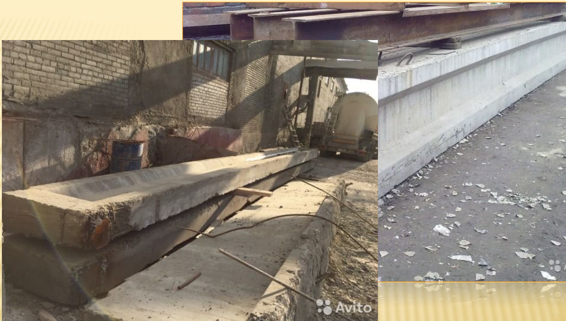
СКЛАДИРОВАНИЕ ЖЕЛЕЗОБЕТОННЫХ СТРОПИЛЬНЫХ БАЛОК
