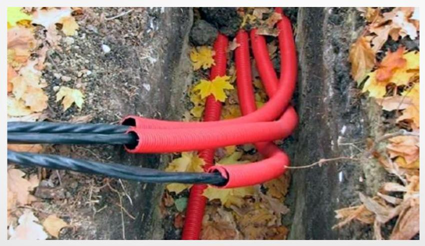
Перед тем, как приобрести гофрированную трубу для защиты силовых проводов в грунте, в обязательном порядке убедитесь, что она не повреждена, осмотрев ее по всей длине. Выбор качественного строительного материала и строгое следование инструкции по монтажу инженерных силовых проводов – это залог их долговечной эксплуатации без угрозы замыканий или других опасных для жизни происшествий.
