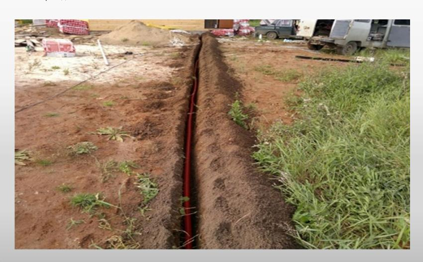
Способ укладки кабеля по защитной гофрированной трубе посредством рытья в земле траншеи идеально подходит для частных домов и дачных участков. Глубина укладки должна быть не меньше 70-80 см. Данный вид монтажа не требует дополнительных соединительных муфт или колодок, а только для вывода провода из-под земли и соединение с электрической системой дома.
