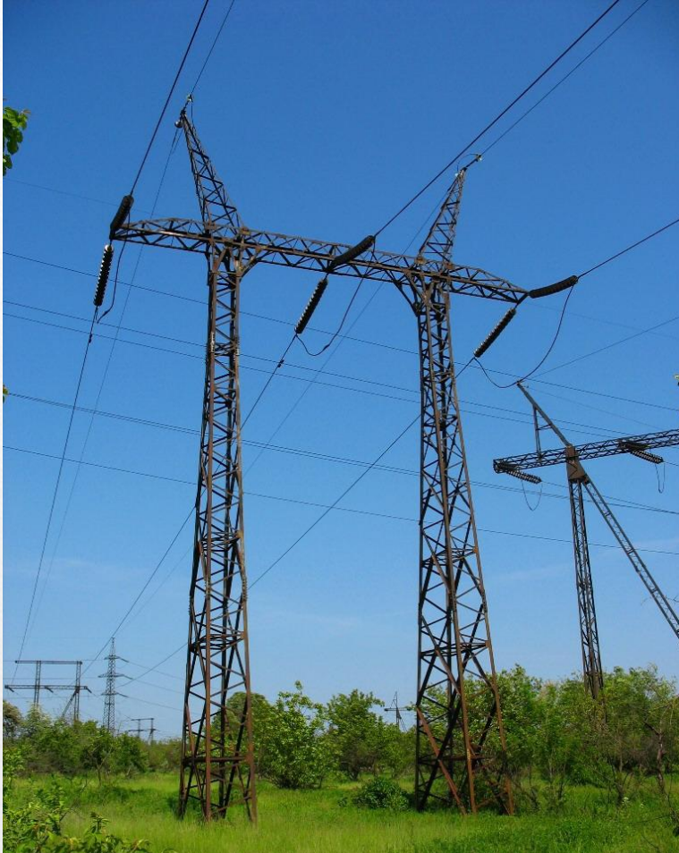
Одноцепная опора порталного типа с горизонтальным расположением проводов
