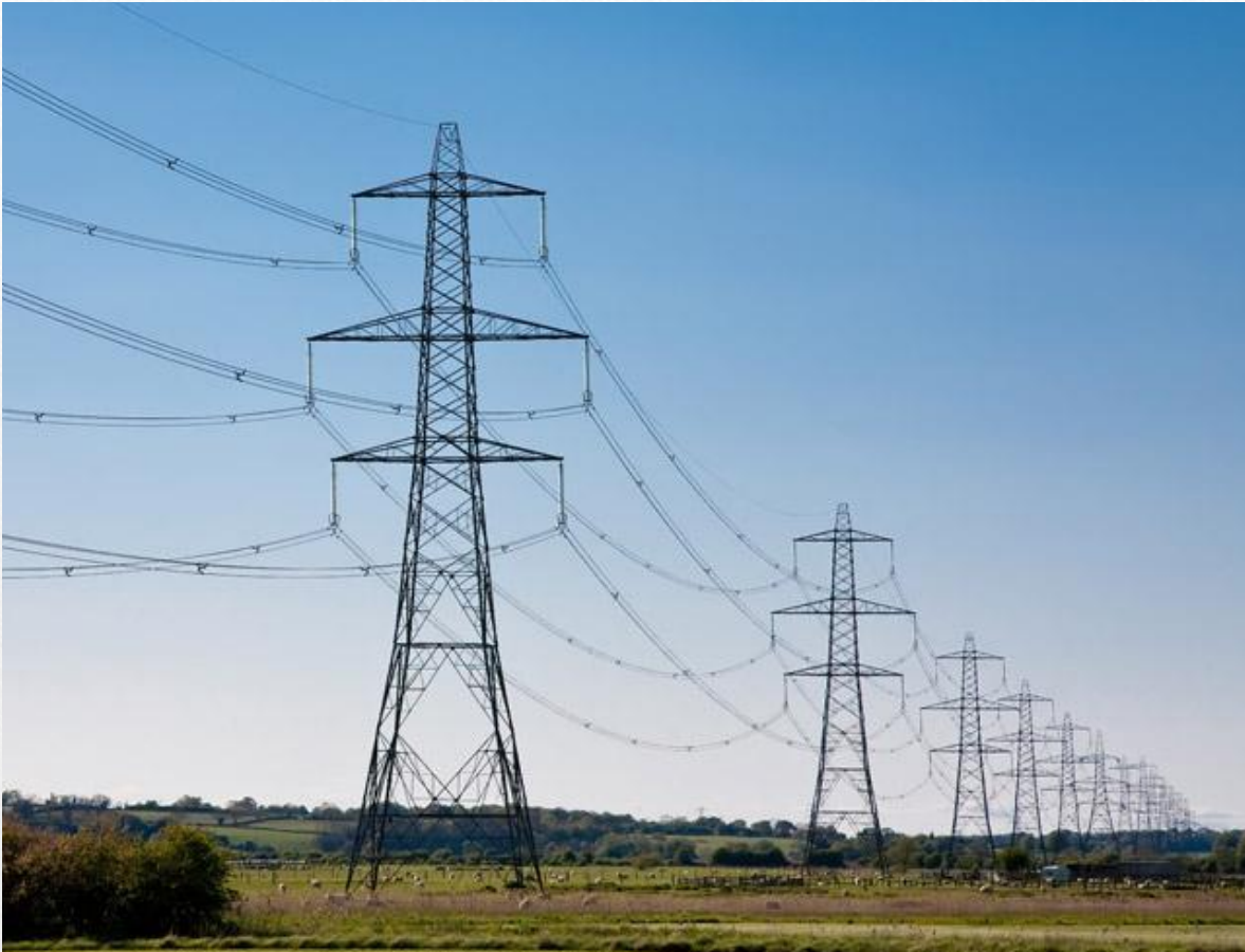
Двухцепная одностоечная широкобазая опора с вертикальным расположением проводов
