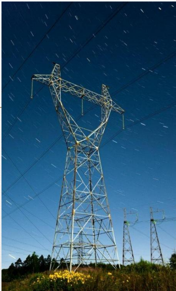
Одноцепная опора башенного типа с горизонтальным расположением проводов
