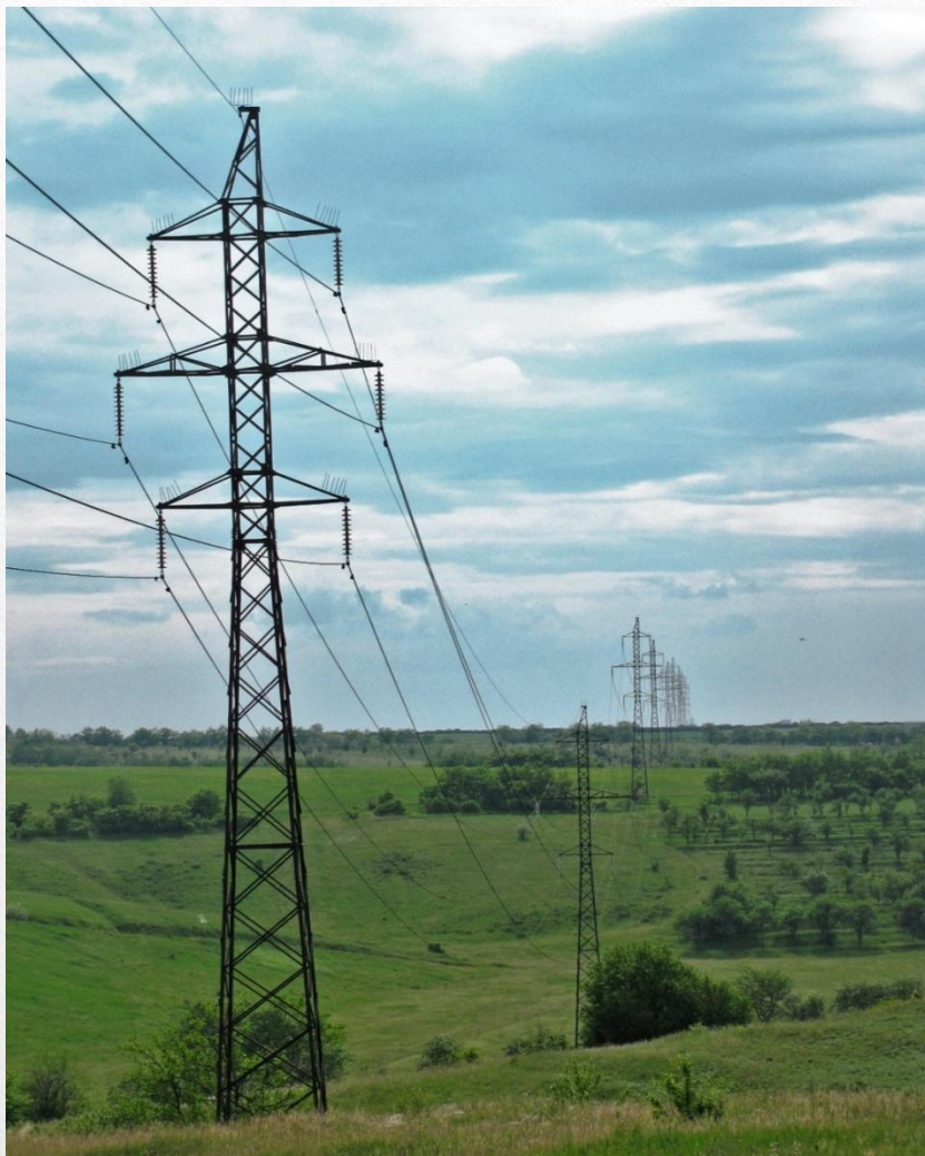
Двухцепная одностоечная узкобазая опора с вертикальным расположением проводов
