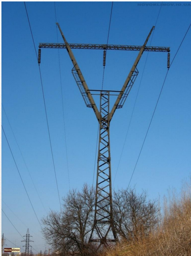
Одноцепная опора типа «Рюмка» с горизонтальным расположением проводов, узкобазая
