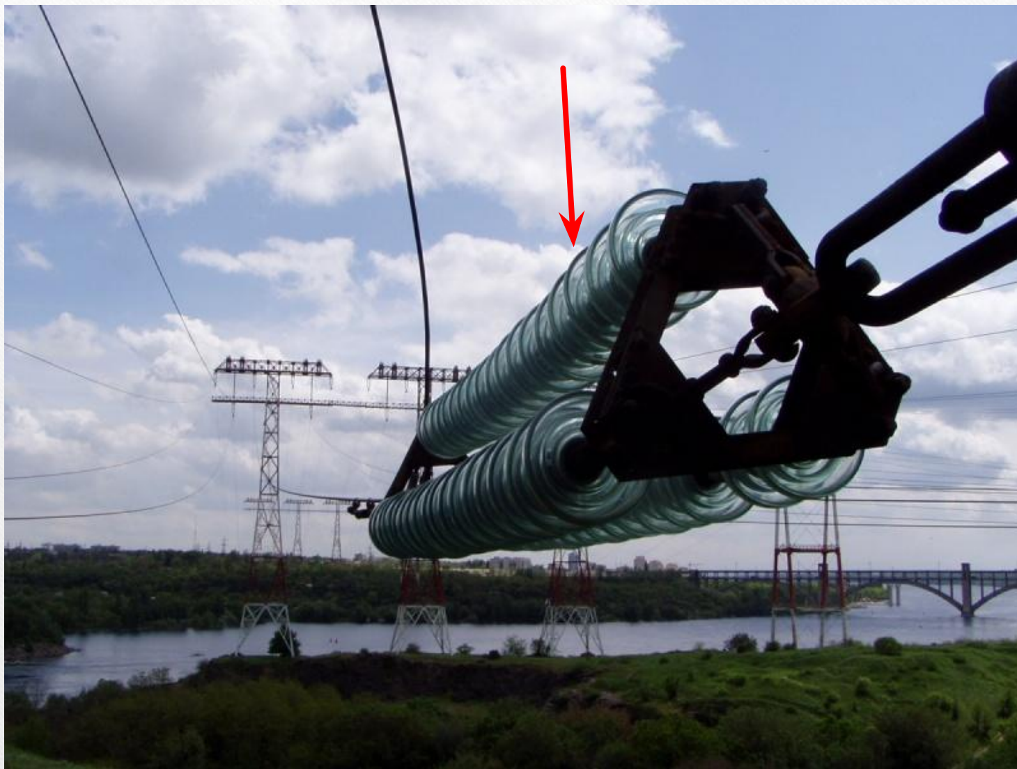
Натяжная гирлянда концевой опоры ЛЭП
