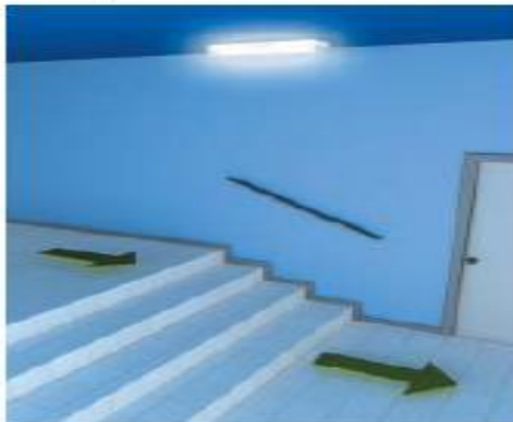
Возле лестниц, чтобы каждая ступенька была освещена
