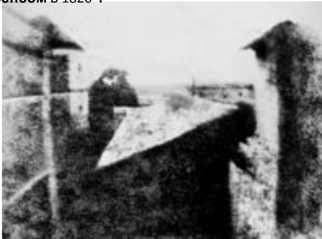
Ньепс получил этот снимок, проэкспонировав в камере-обскуре пластинку из сплав олова и других металлов размером 16,2×20,2 сантиметров, покрытую сирийским асфальтом (битумом). Из-за низкой светочувствительности экспозиция длилась не менее 8 часов при ярком солнечном свете.
