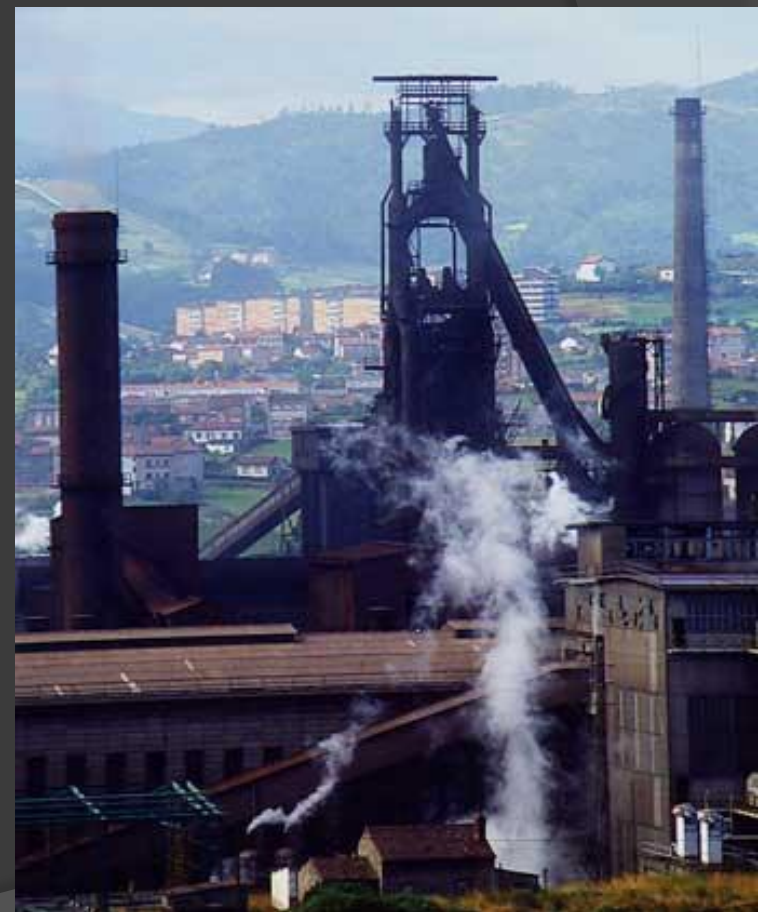
ДОМЕННАЯ ПЕЧЬ в Авилесе (Испания).
