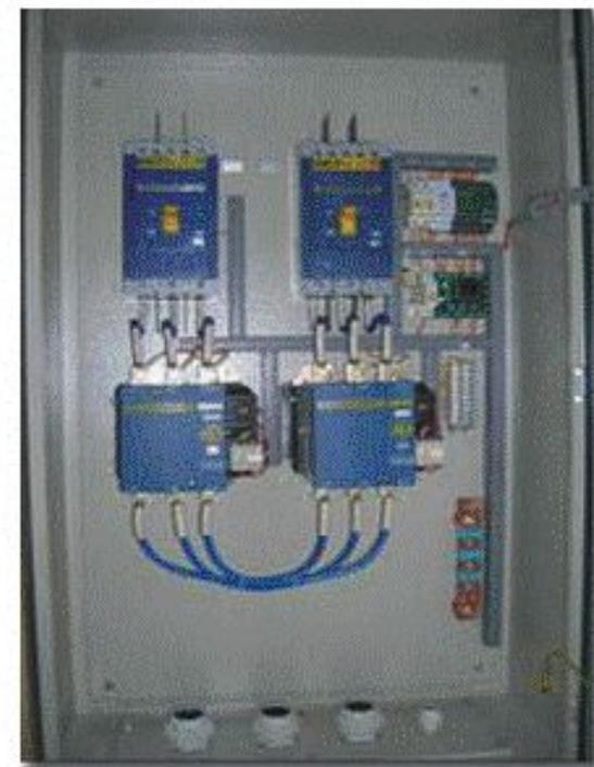
Щит Автоматического Ввода Резерва (АВР) представляет собой комплектное устройство и предназначен для подключения потребителей к дизельному агрегату при исчезновении напряжения на основном вводе.
