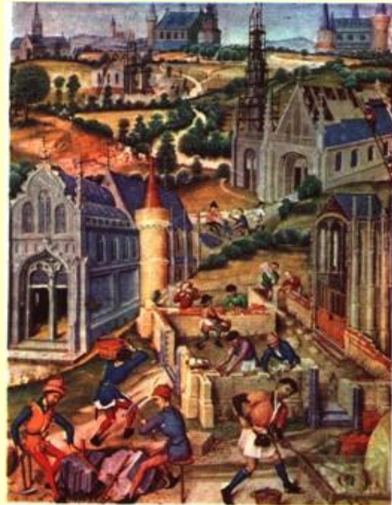
Строительство городских зданий
