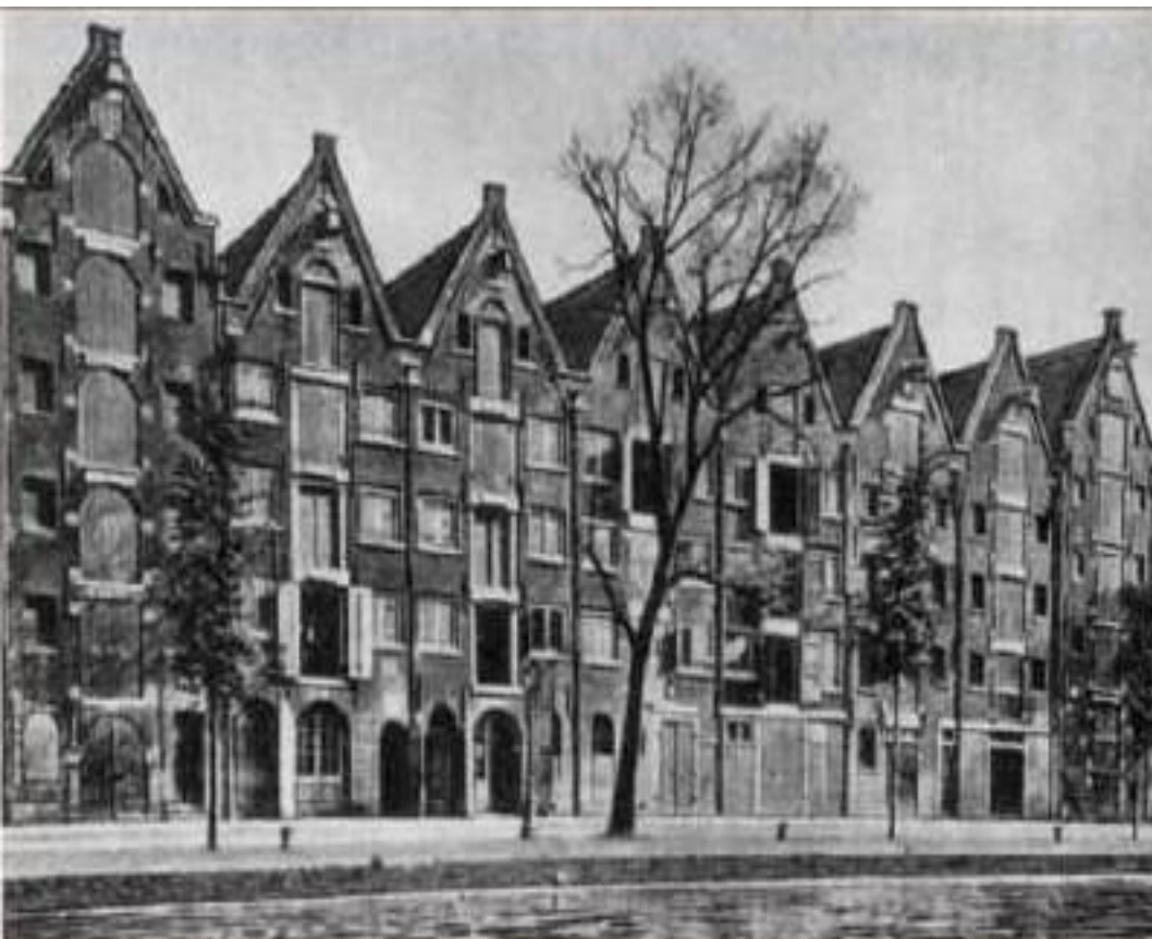
Амстердам. Здание складов
