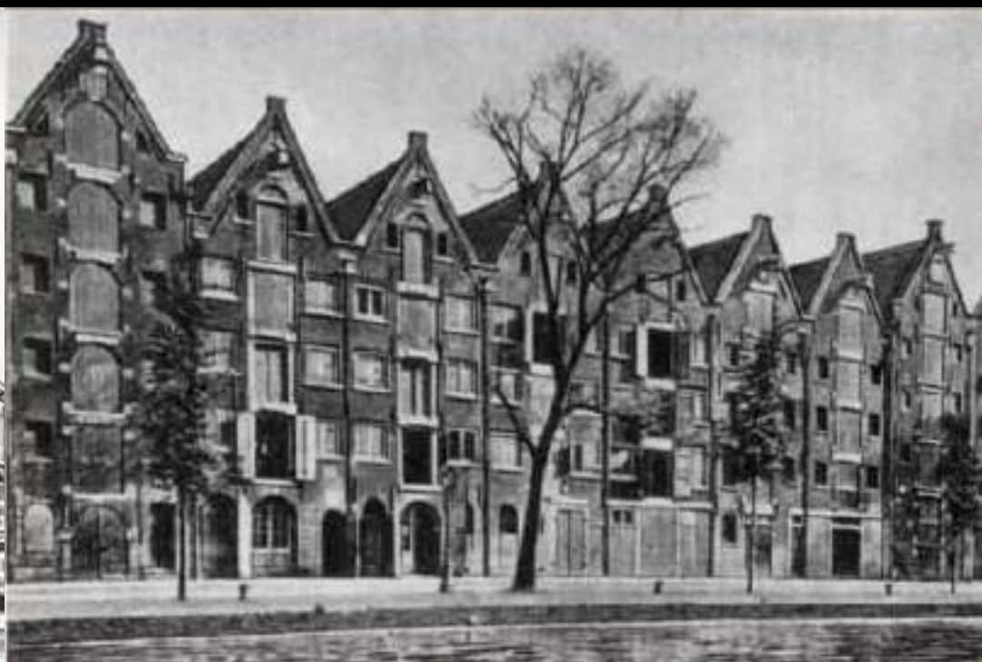
Амстердам. Здание складов
