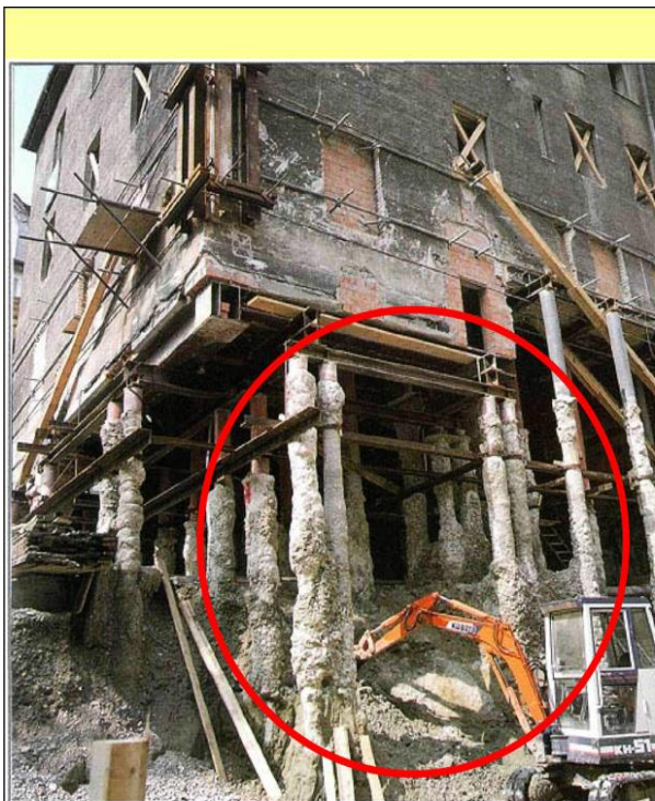
Пересадка старого фундамента на буринъекционные сваи
