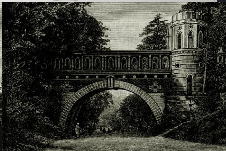
Фигурный мост через дорогу (Царицыно)
