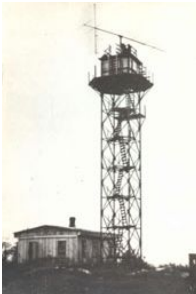
РЛС под Токсовым. Дальность действия до 200 км
