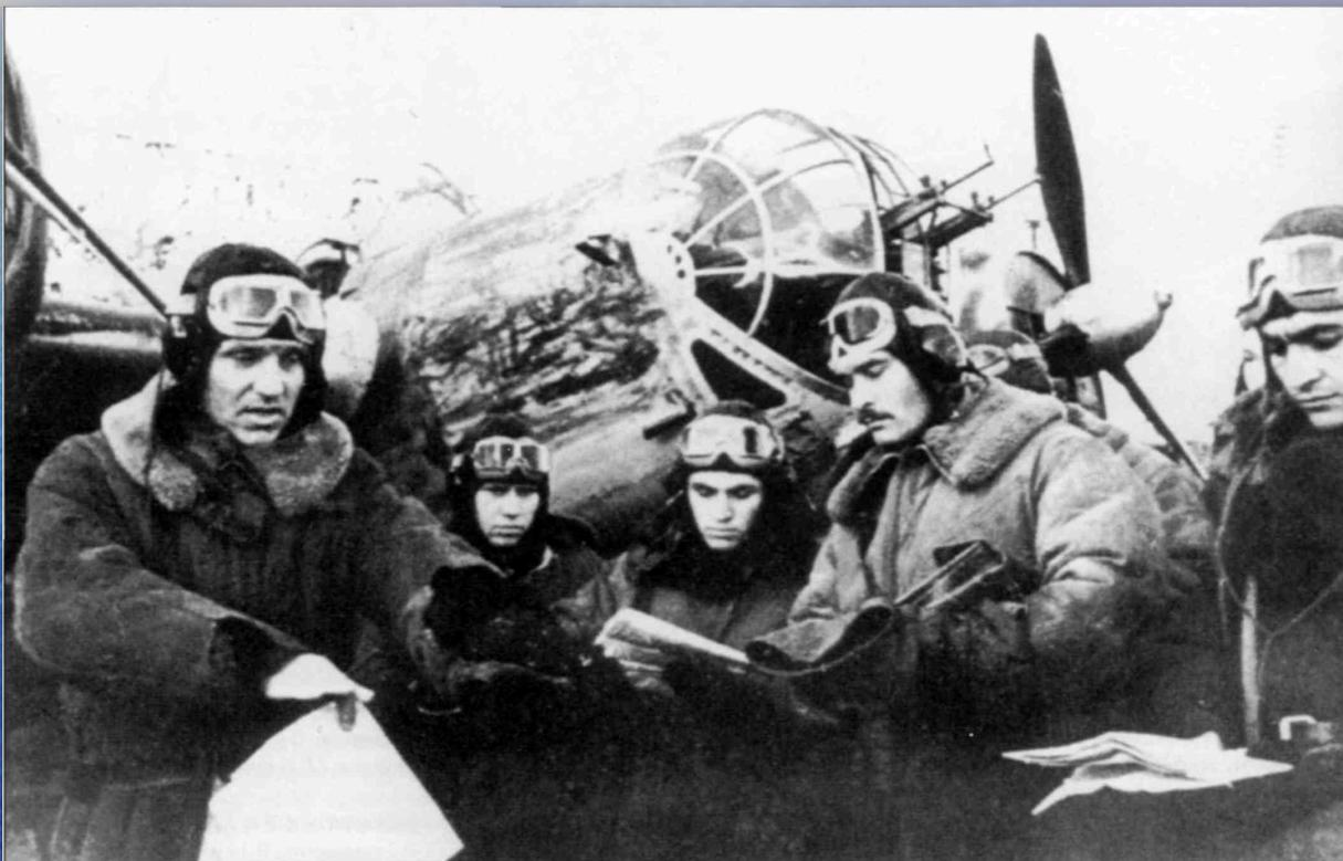
*Экипажи СБ с моторами М-100А советских ВВС перед боевым вылетом, война с Финляндией, 1939 - 1940 г.г. Верхняя трубка Вентури на правом борту в носовой части фюзеляжа на поздних СБ-2-М-100А отсутствовала. Камуфляж из пятен зеленого цвета покрашен от руки кисточкой по голой дюралевой обшивке.*
