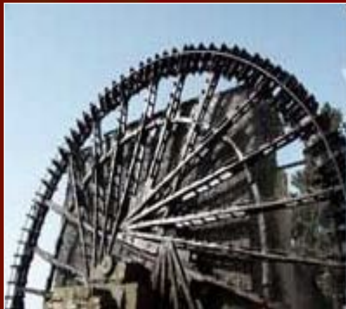
Норія – давнє водопідйомне колесо, яке діяло під дією течії річки
