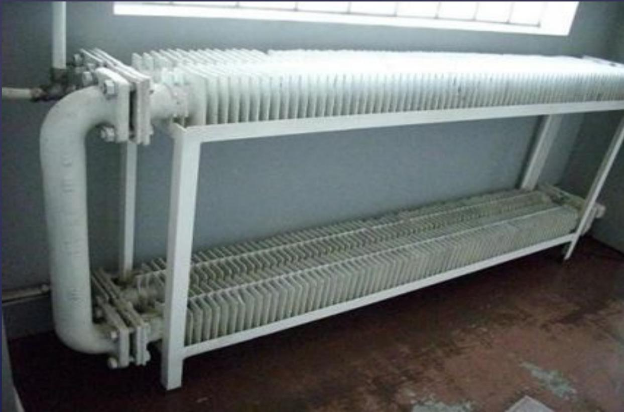
4. Стальные штампованные радиаторы. Представляют собой два шпательных стальных места, соединенных между собой контактной сваркой.
