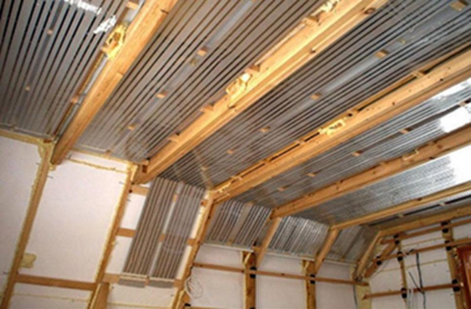
Рис. 18. Потолочный ИК- обогреватель
