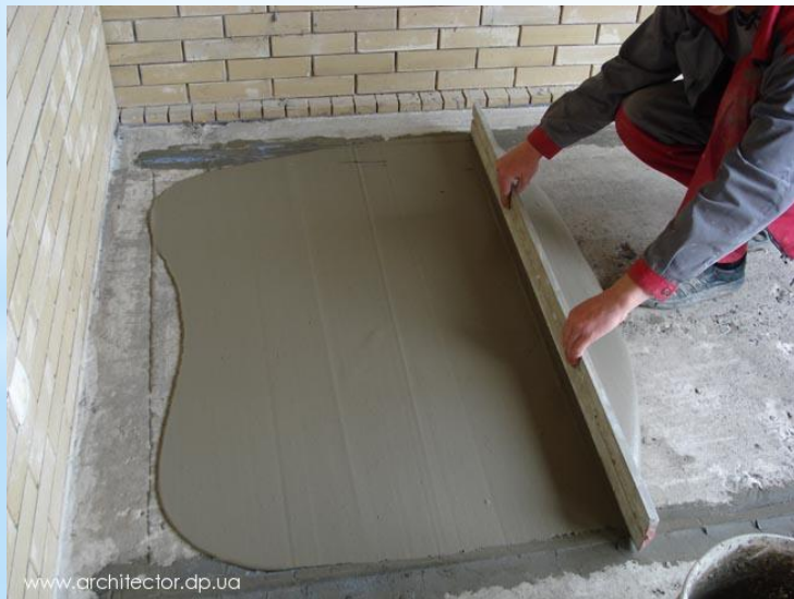
выравнивание стяжка (основание для укладки чистового пола)
