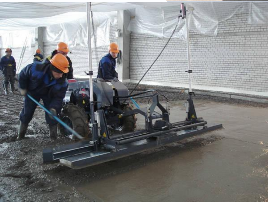
Виброрейка (распределение и бетона)
