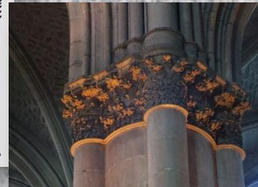
С появлением крестового свода и системы «оголенных» конструкций, храмы приобрели вид громадных мистических сооружений. Система аркбутанов и контрфорсов позволила сильно облегчить каменную конструкцию за счет перераспределения нагрузок. Стены перестали выполнять несущую функцию и превратились в «легкую оболочку», состоящую из кружева огромных окон. На смену традиционной стенной росписи приходят витражи, на смену масштабному
