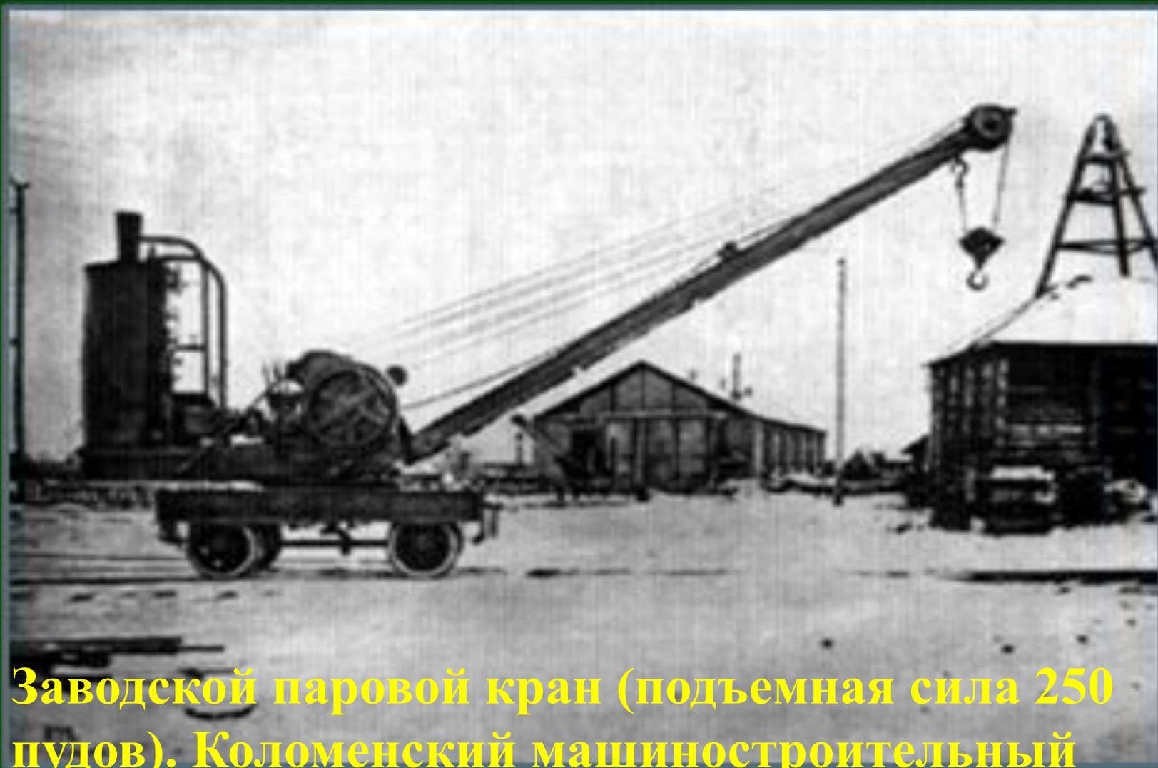
**Заводской паровой кран (подъемная сила 250 пудов). Коломенский машиностроительный завод.**
