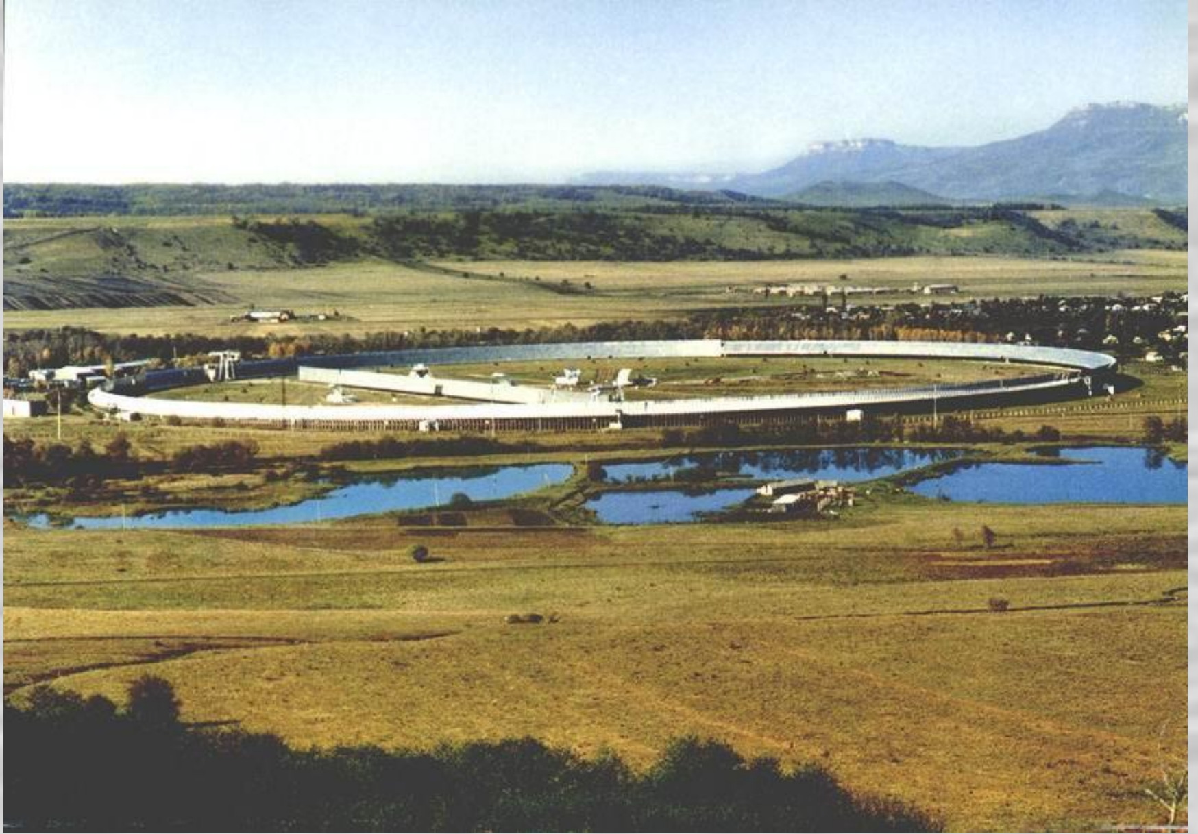
Радиотелескоп РАТАН- 600, Россия(Сев.Кавказ) , вступил в строй в 1967г , состоит из 895 отдельных зеркал размером 2,1x7,4м и имеет замкнутое кольцо диаметром 588м
