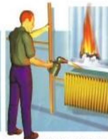
Отогревание замёрзших труб паяльными лампами и факелами, нарушение правил проведения сварочных работ
