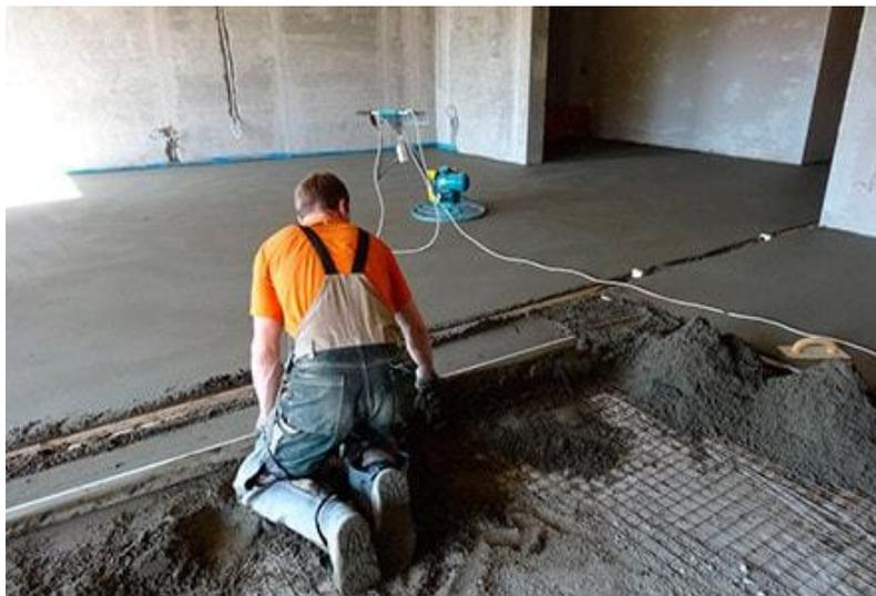
Стяжка пола — представляет собой слой (как правило, цементно-песчаный), который относится к структуре пола в качестве основы для напольного покрытия.
