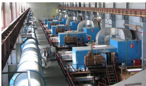
ГТУ-16П в составе ГПА-16РП «Урал» на КС-18 Ординская, ООО «Газпром трансгаз Чайковский»
