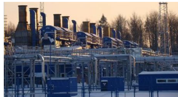
ГТУ-6ПГ в составе ГПА-6ДКС на Южно-Приобское МНГ, ООО «Газпромнефть-Хантос»
