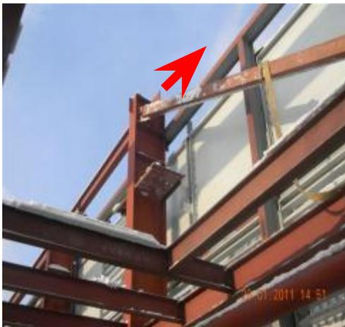
26.01.11 монтажник отстегнул карабин монтажного пояса начал перемещаться с наружной стороны колонны по верхней балке аэрационного фонаря, в этот момент потерял равновесие и упал
