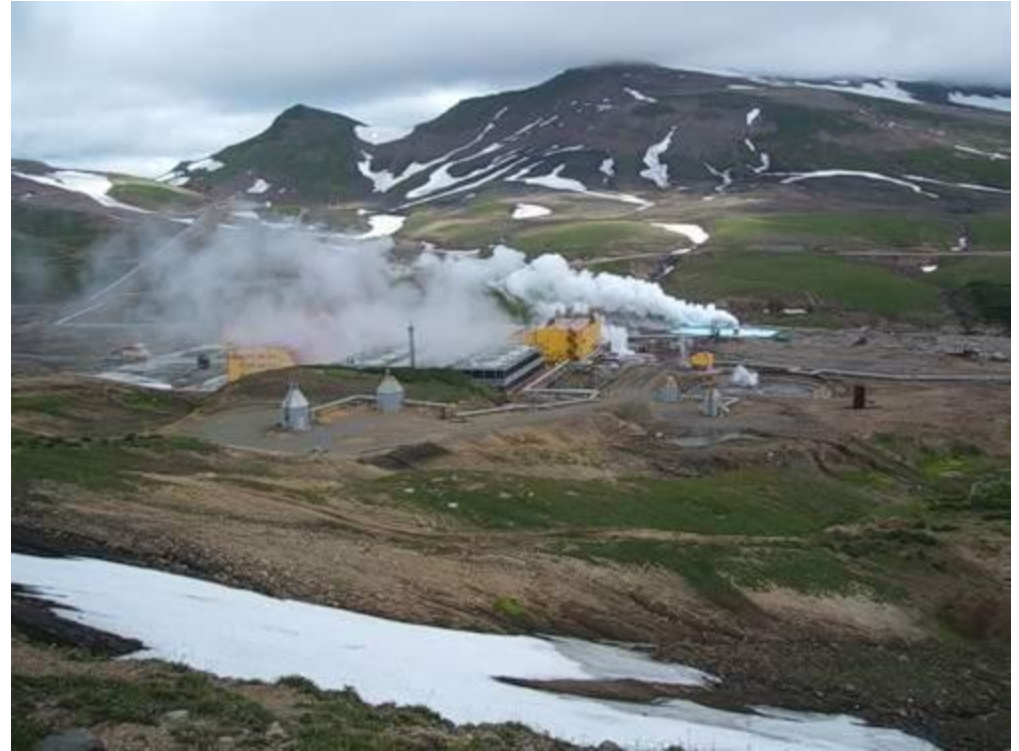
Мутновская геотермальная станция
