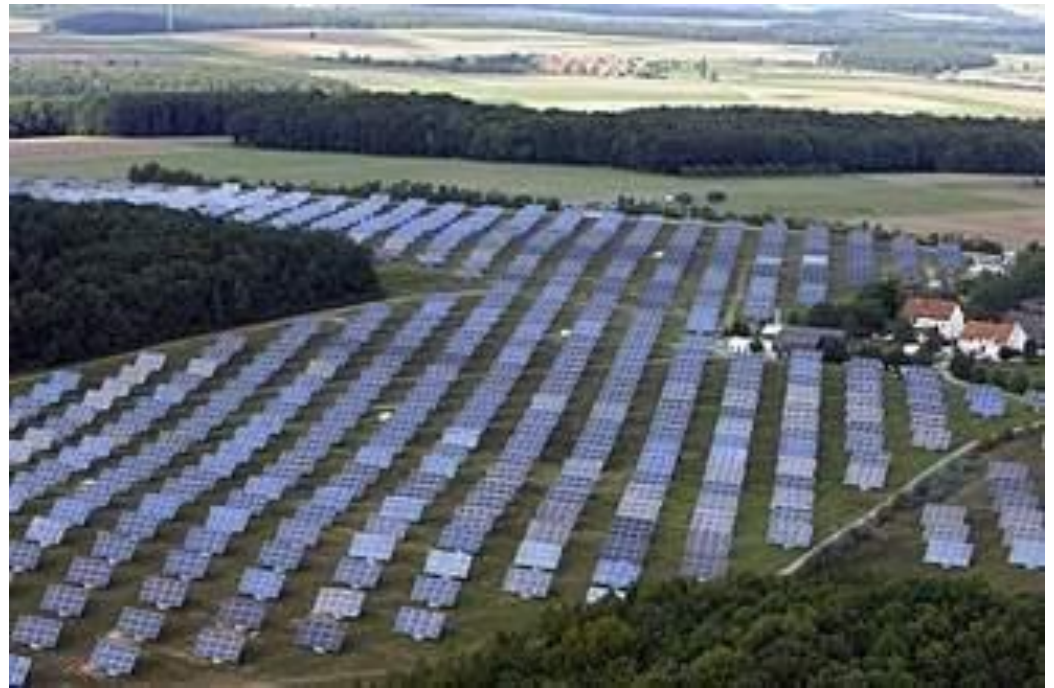
Солнечная электростанция в Германии
