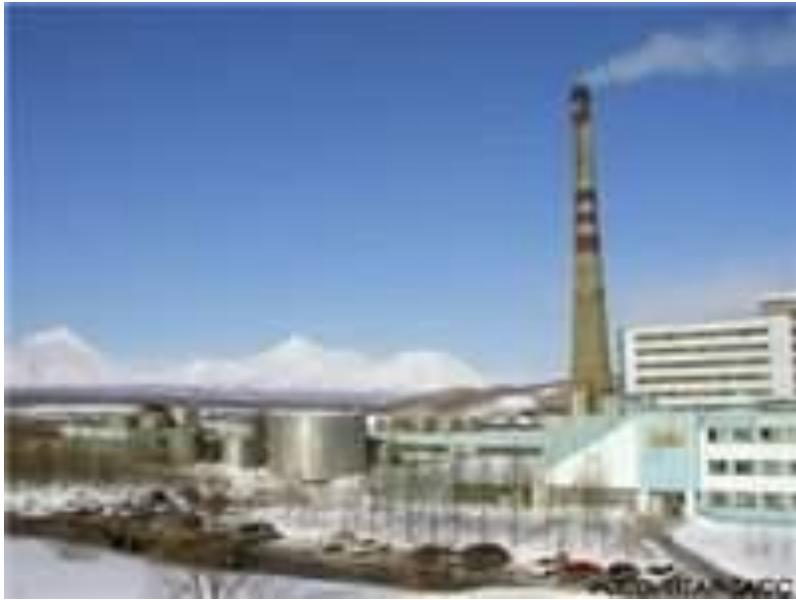
Паужетская геотермальная станция
