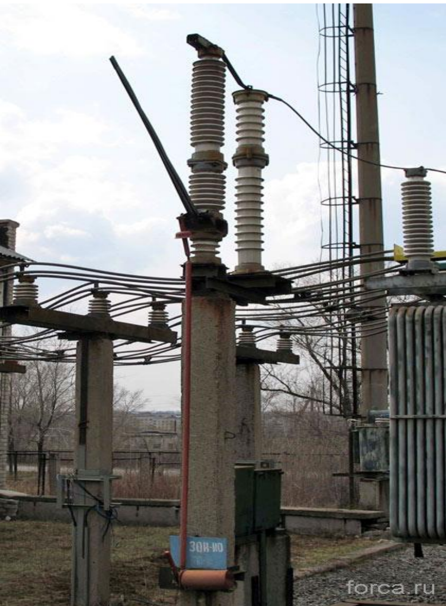
Заземлитель типа ЗОН-110
