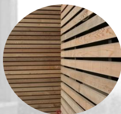
Отделка цоколя бани деревянной решеткой
