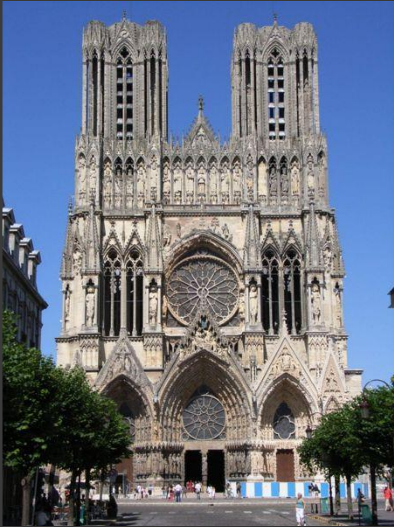
Фасад Реймского собора
