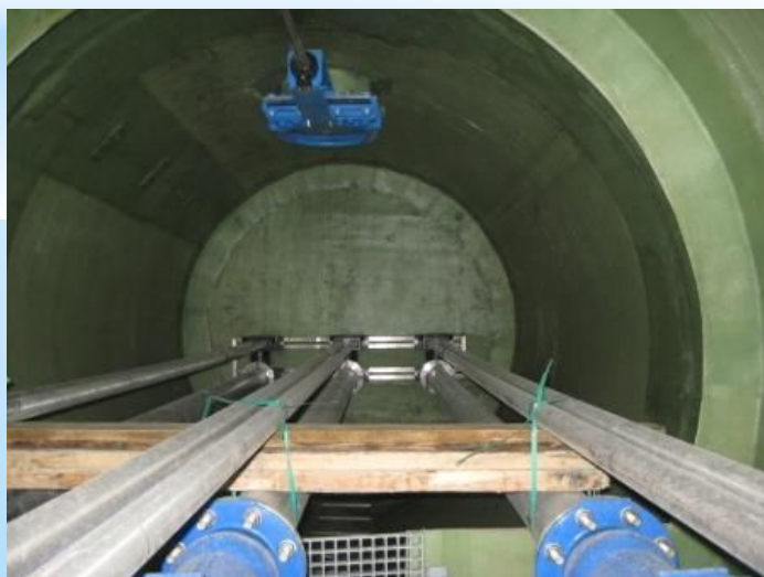
КНС из стеклопластика (вид внутри)
