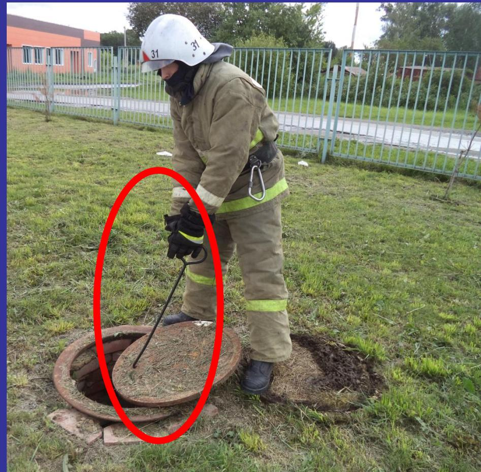
При проверке ПГ недостаточно использовать только ключ, необходимо навернуть пожарную колонку и таким способом установить работоспособность гидранта.
