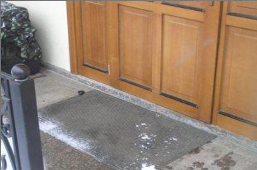
Труба теплого пола уложена близко к наружной стене. Теплоноситель в системе охлаждается более интенсивно и его приходится подогревать чаще. Результат - увеличение затрат на отопление.
