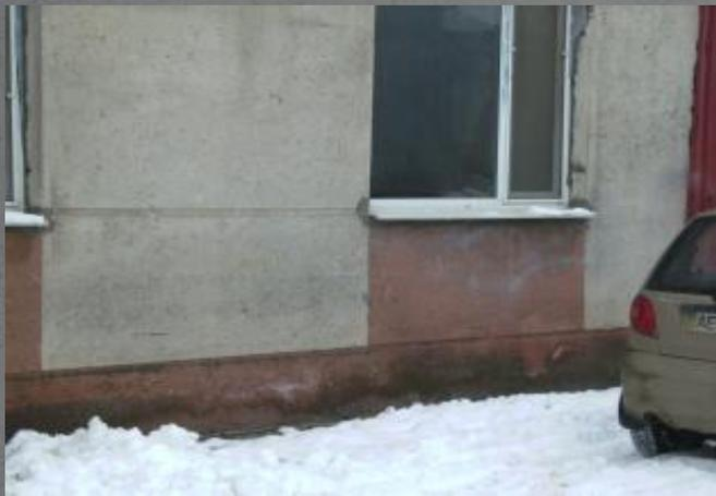
Еще один пример неэффективной работы радиатора. Внутри помещения установлен радиатор, который очень сильно нагревает стену. В результате часть выделяемого им тепла уходит на улицу. Фактически тепло используется для обогрева улицы.
