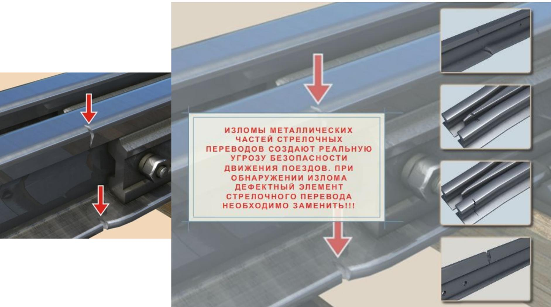
**разрыв контррельсового болта** в одноболтовом или обоих в двухболтовом вкладыше
