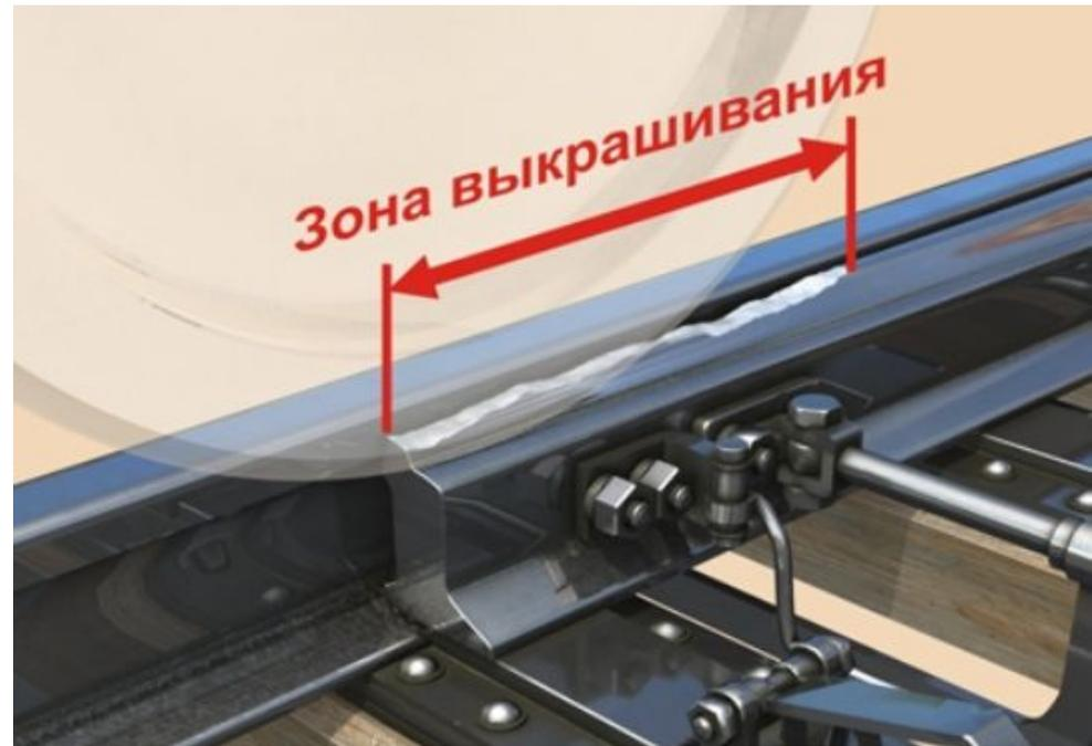
**понижение остряка** против рамного рельса и подвижного сердечника против усовика на 2 мм и более, измеряемое в сечении, где ширина головки остряка или подвижного сердечника поверху 50 мм и более
